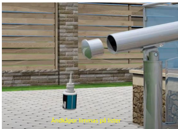
Ledstänger anpassas och limmas i monteringsbeslag Lister kan förkortas med geringssåg eller bågfil
